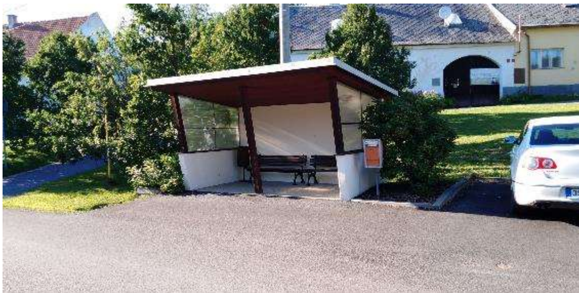
Obrázek 10 – Autobusová zastávka "Škola" v Dolní Rudné
