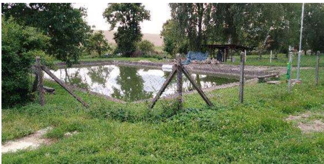
Obrázek 7 – Požární nádrž v obci Rudná
