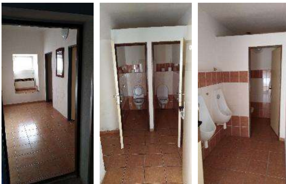
Obrázek 26 – Kulturní dům v Rudné – zrekonstruované sociální zařízení
