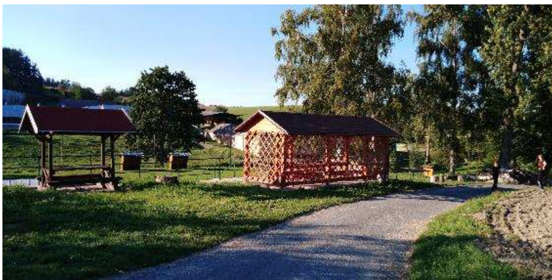
Obrázek 32 – Sportovní areál s fotbalovým hřištěm v Rudné - altán
