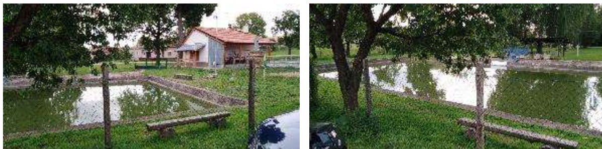
Obrázek 38 – Požární nádrž v Rudné
